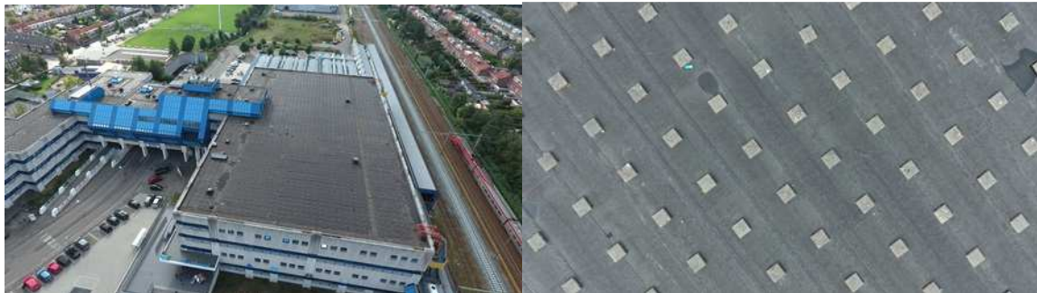
Detailopname van de daken van de gebouwen. Bitumen dakbedekking zonder grind. Dergelijk daken zijn ongeschikt als nestplaats voor vogels zoals meeuwen, scholekster en sterns. Foto: Natuurbank Overijssel.
